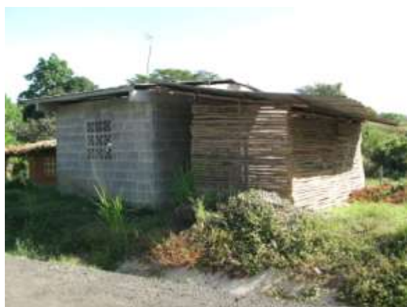
Foto 24. Vivienda de concreto con rancho auxiliar.
